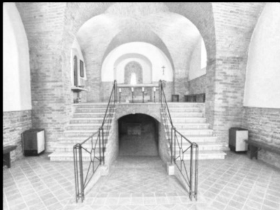
Sono iniziati i lavori per la ristrutturazione dell'abbazia dei Santi Benedetto e Mauro
